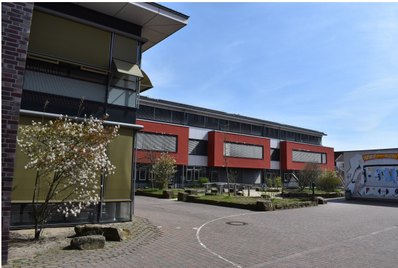
Abb. 2.59: Oberschule Bersenbrück Süd
