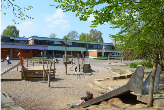
Abb. 2.61: Turnhalle Grundschule Ankum
