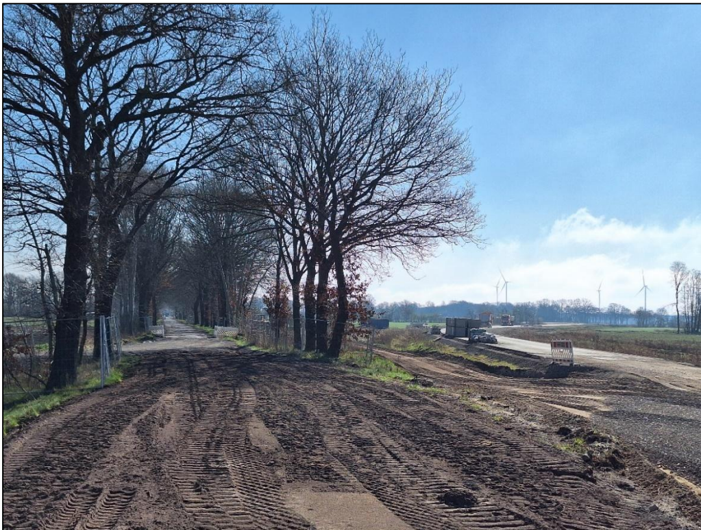
Abbildung 9: Riester Damm im zentralen Plangebiet
