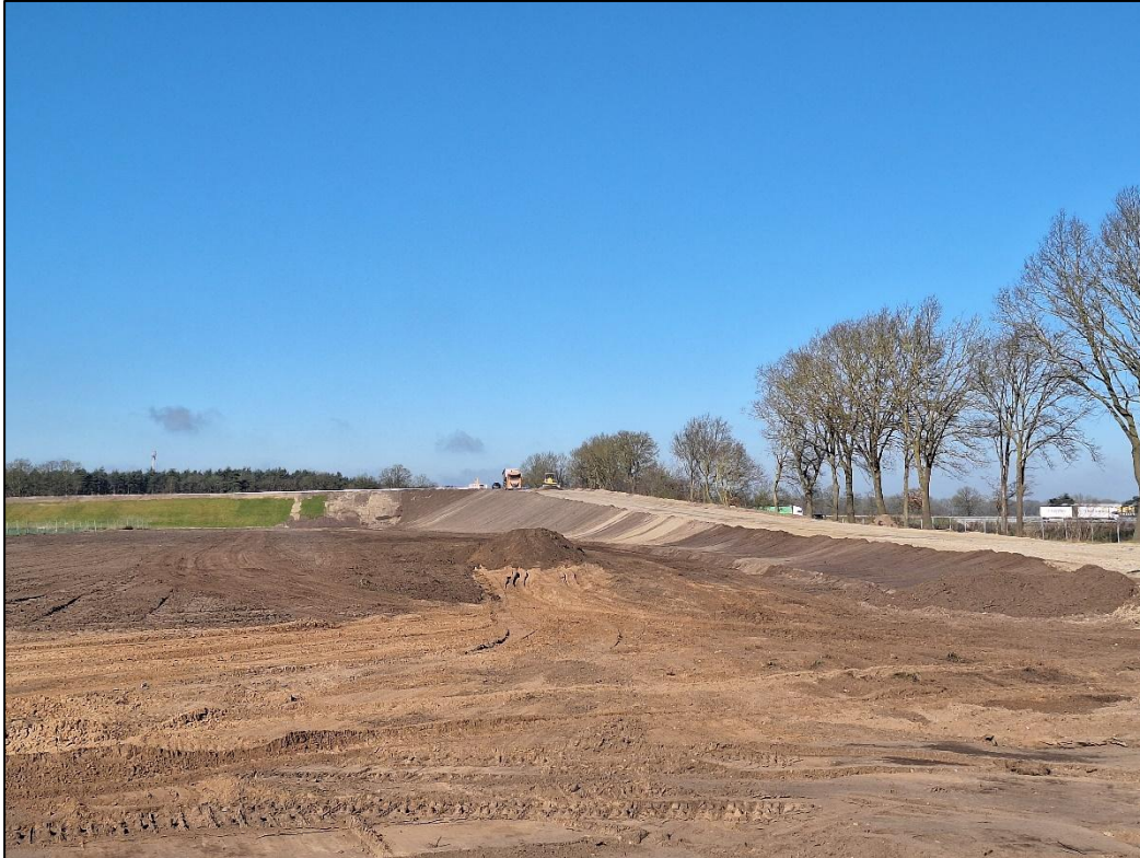
Abbildung 10: Baustelle zum Anschluss an die BAB 1 im östlichen Plangebiet
