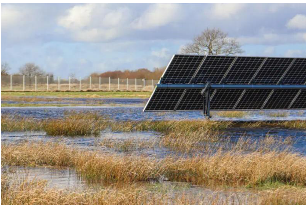
Abb. 5: Moor-PV-Anlage auf einer wiedervernässten Fläche
