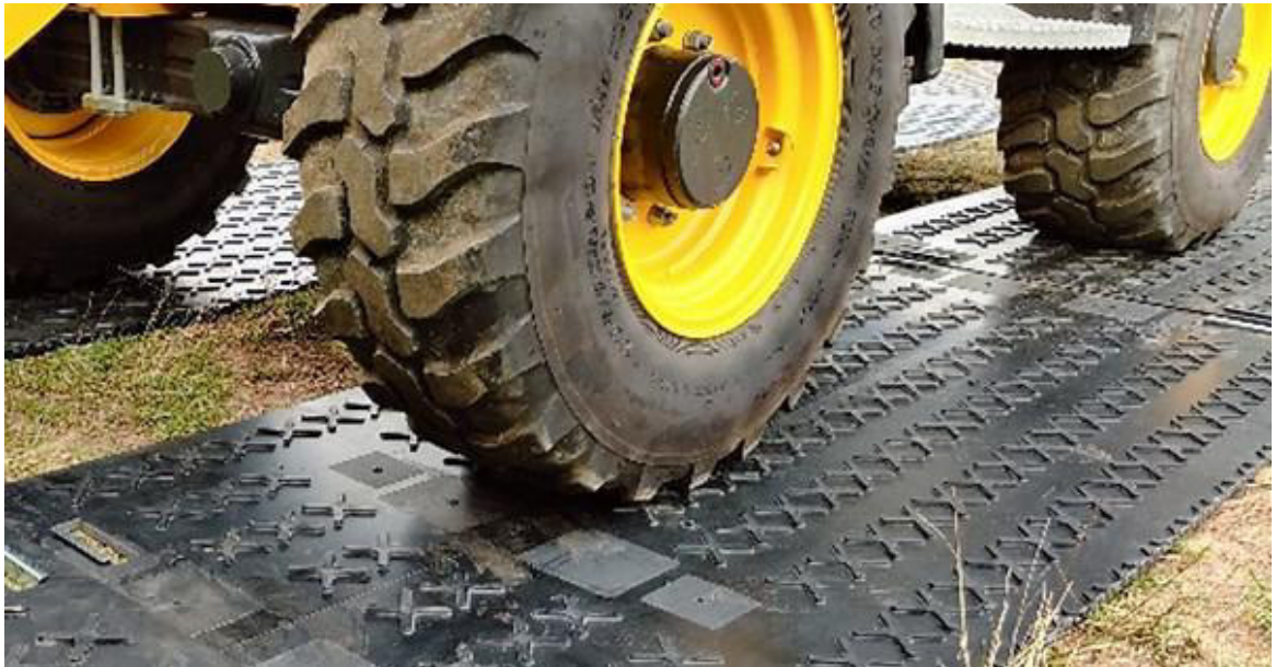
Abb. 6: Verminderung der Bodenverdichtung durch Verwendung von Fahrplatten aus Kunststoff
