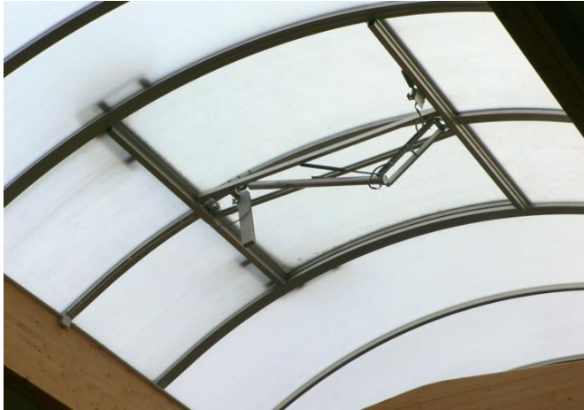
Abbildung: RWA-Klappe im Dachfirst
