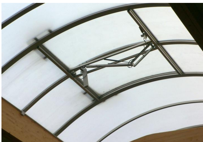
Abbildung: Lichtband und RWA-Klappe im Dachfirst
