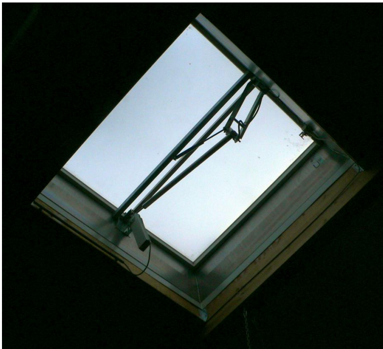
Abbildung: RWA-Lichtkuppel im Dach
