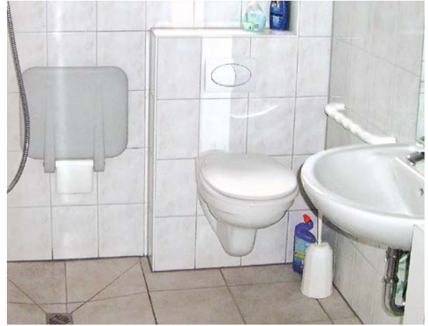
Nachher: Durch den Umbau wurde Bewegungsfreiheit geschaffen.
