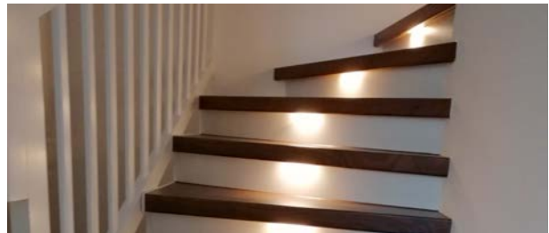
Die Stufenbeleuchtung wird über Bewegungsmelder gesteuert.
