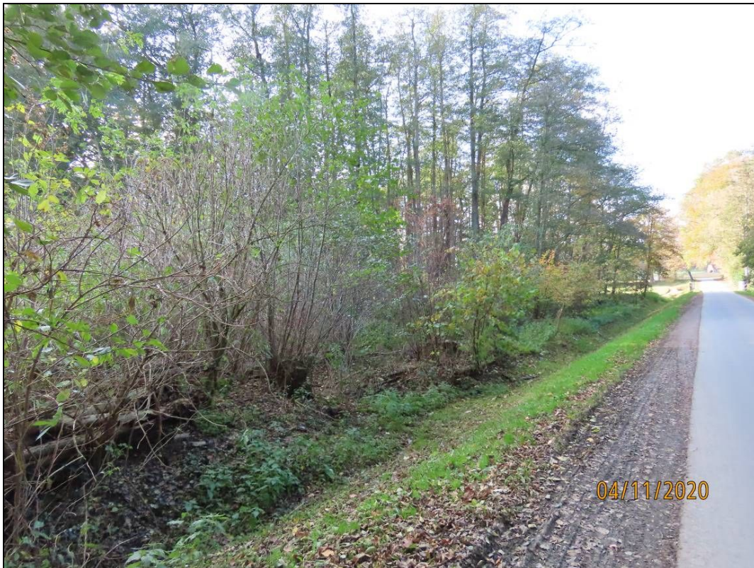
Abb. 6: Nach Westen in den Suttruper Bach abführender Graben (BIO-CONSULT 2020)
