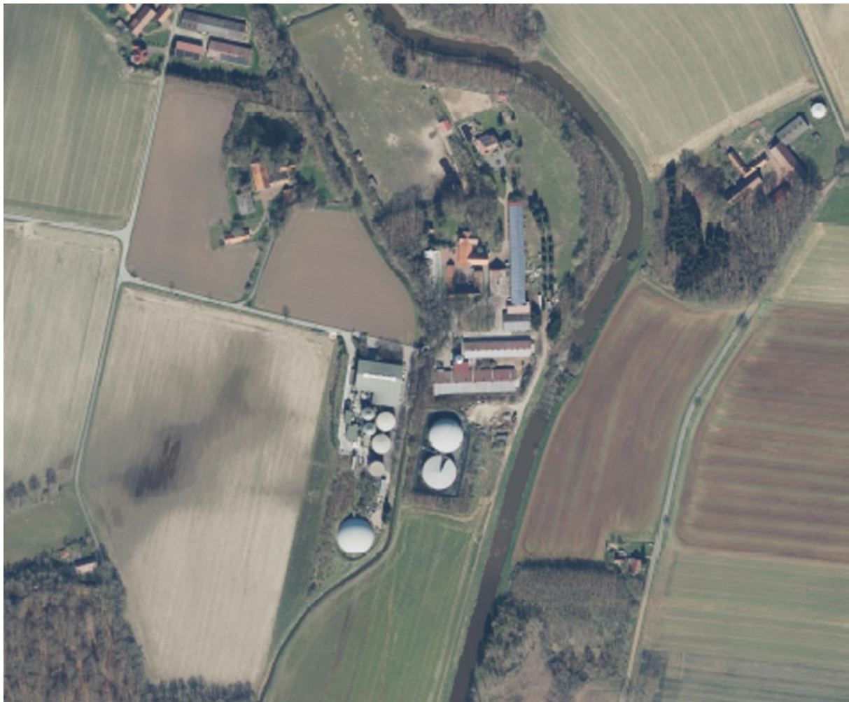
Abb.: Luftbild vom Änderungsbereich mit angrenzenden Nutzungen (Open Geo Data, LGLN)
