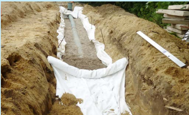
Abbildung 12: Rohrrigole
