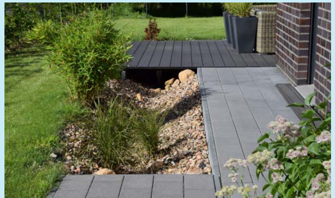
Abbildung 8: Versickerungsgraben
