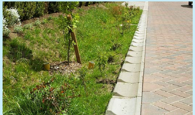
Abbildung 11: Mulden-Rigolen-System
