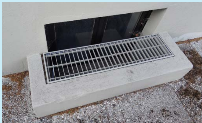
Abbildung 22: Aufkantung am Kellerfenster
